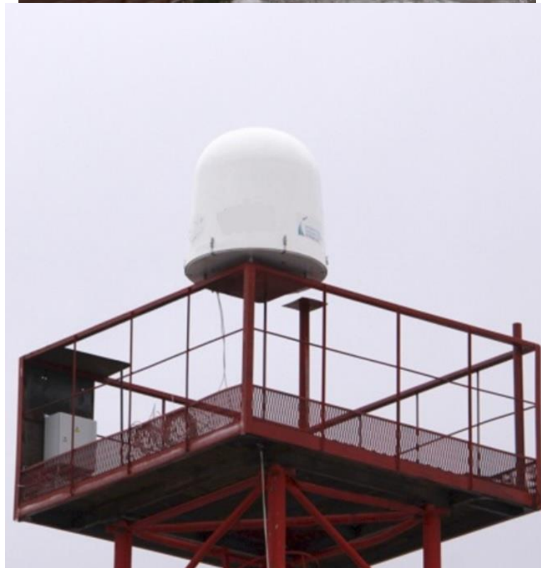
Рисунок 4.26 – Размещение МРЛК БАЗ на специальной мачте (вышке)
